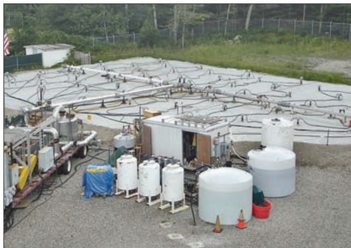
Trattamento di desorbimento termico in situ
