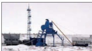
Impianto di inertizzazione fanghi
